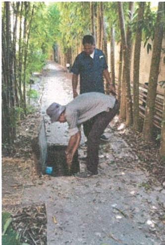
รูปภาพที่ 2.13 บ่อพักน้ำขนาด 1 ลูกบาศก์เมตร
