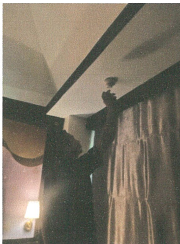
รูปภาพที่ 2.22 การตรวจสอบอุปกรณ์และแจ้งเตือนอัคคีภัย
